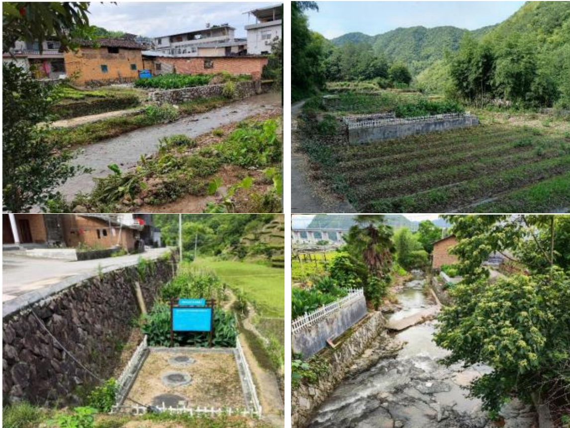
图 2.1-4 现状污水处理终端
